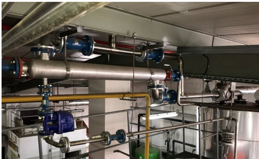
Rysunek 6. Przykład zabudowy wymiennika odzysku ciepła oparów z procesu odgazowania termicznego na kotłowni parowej
