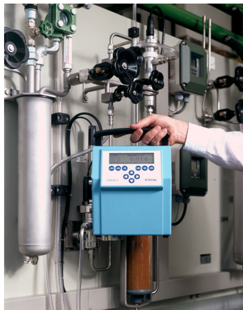
Rys. 17 Automatyczny pomiar przewodności wody kotłowej za chłodnicą próbki na kotłach >60bar
