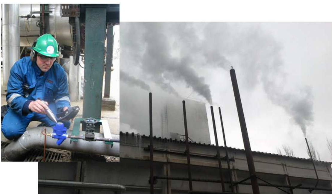
Rysunek 6. Regularna ultradźwiękowa kontrola odwadniaczy ogranicza straty pary
